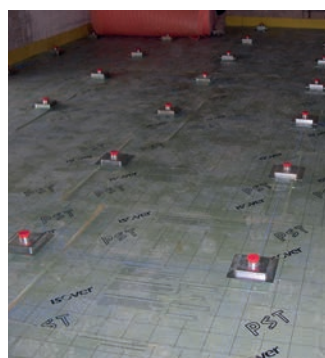
Predisposizione del locale e montaggio dei supporti.
