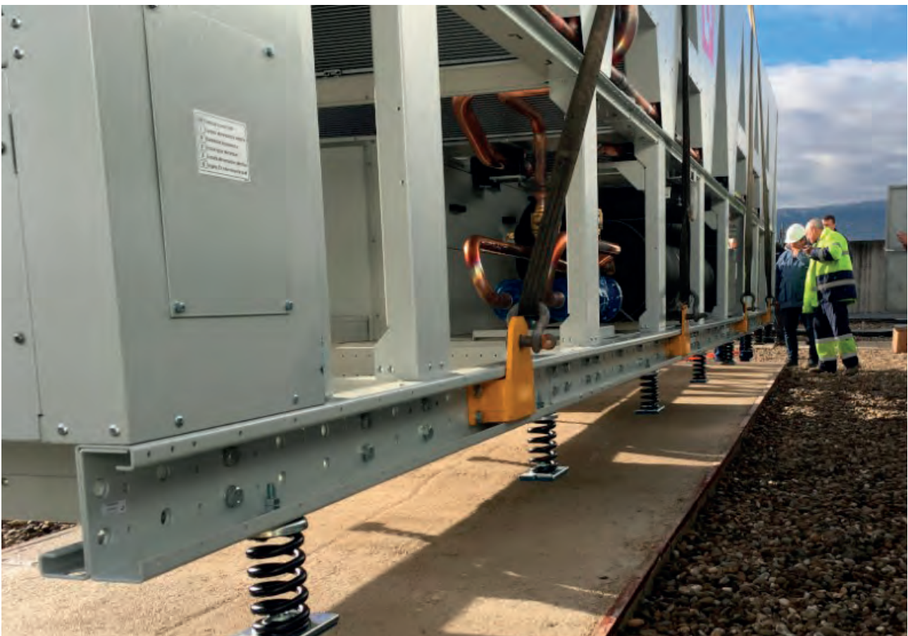
Schwingungsisolierung eines Ventilators mit Vibrabsorber
