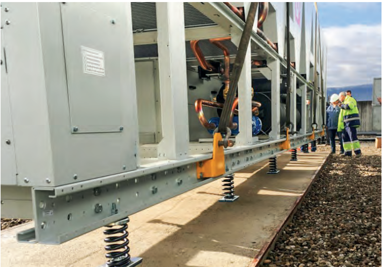
Sistema de ventilación aislado con VIBRABSORBER+Sylomer®
