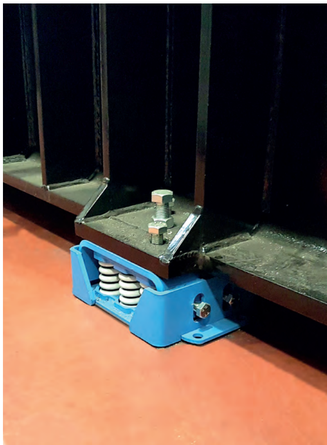
Sistema di ventilazione isolato con VIBRABSORBER ® +Sylomer ®
