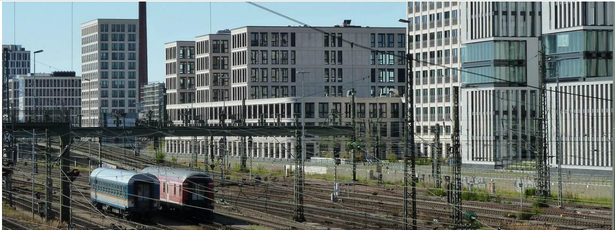
Figura 1: Nueva construcción de Arnulfpark en Múnich (2008); vías colindantes al sur.
