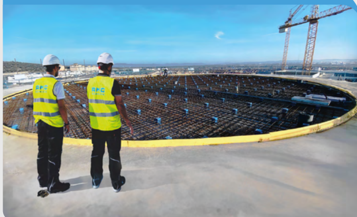
INSTALACIÓN DEL FZH2M
